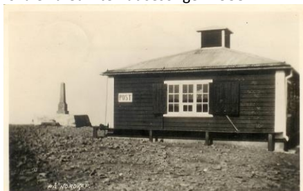
Post- og kafebygningen på Nordkapp-platået, ca 1933-1934. Posthuset var i funksjon fra 1928 til 1939.
