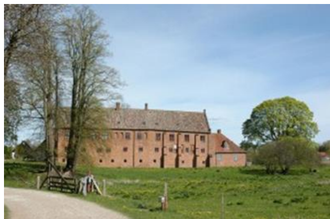
Det tidligere Esrum kloster som Simon Bengtsson rømte fra.
