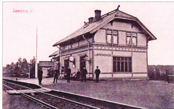
Lørenskog stasjon og første poståpneri. Postkortet er brukt i 1911. Utgitt av G.B. (eid av Narvesen). Til venstre på veggen mot sporet kan man skimte noe som trolig er en rød postkasse, en oppslagstavle (uthengskasse) fra postvesenet og et firkantet postskilt i støpjern.
